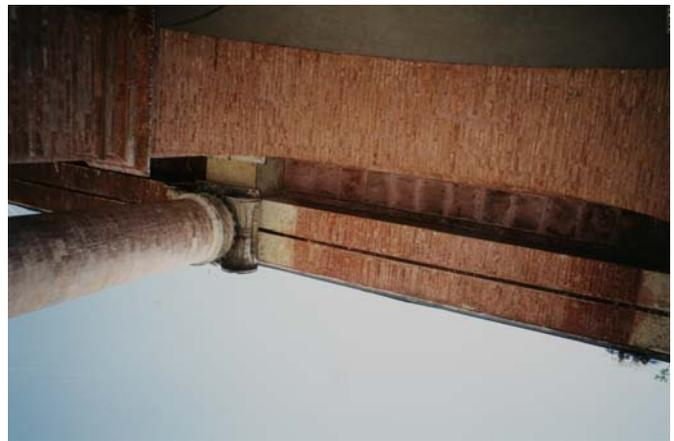
Da quest'ultima partono, attraverso perforazioni, dei cavi in acciaio che si agganciano ai profilati all'interno degli architravi, creando un sistema di sostegno e di rinforzo. La pavimentazione dei terrazzini è stata successivamente ripristinata e resa calpestabile.
